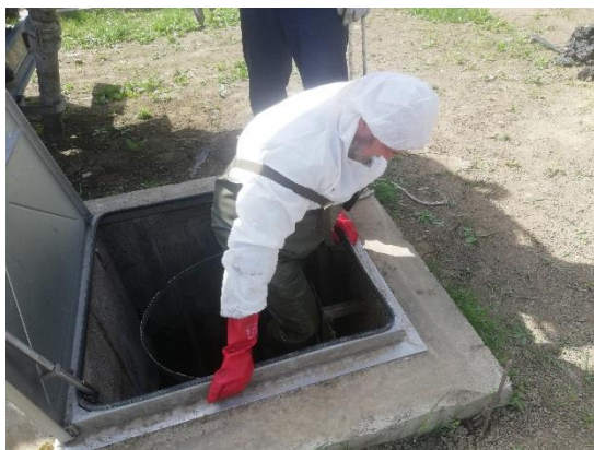
Slike 5. i 6. Ručno i strojno vađenje vlažnih maramica iz objekata javne odvodnje
