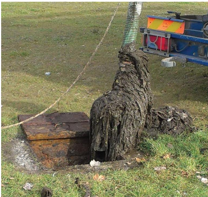
Slika 1. Vađenje vlažnih maramica i drugog nerazgradivog otpada iz kolektora naselja Olajnica
