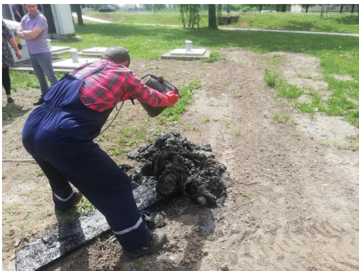
Slika 2. Vađenje vlažnih maramica iz crpne stanice Borovo1
